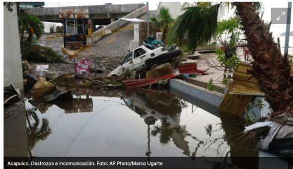
Acapulco. Destrozos e incommuniación. Foto: AP Photo/Marco Ugarte
